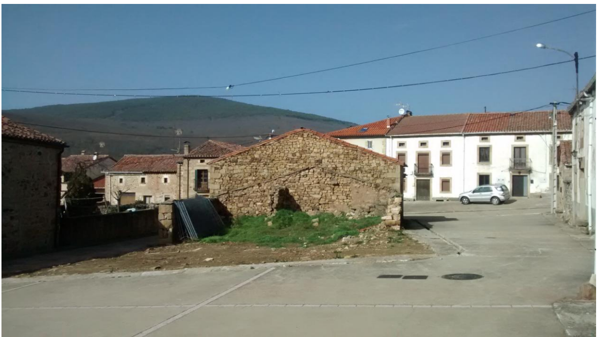
PARCELA C/. SOLEDAD nº 25 (SUR) EDIFICACIÓN DEMOLIDA
