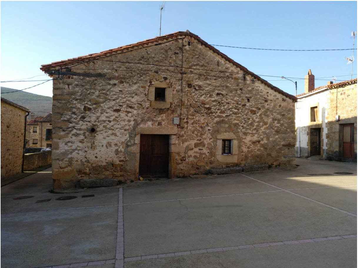
PARCELA C/. SOLEDAD nº 25 (SUR) EDIFICACIÓN SIN DEMOLER
